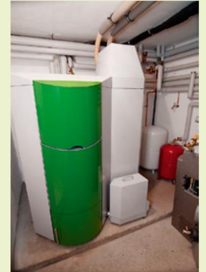
Effiziente Holz-Zentralheizungen gibt es für die Feuerung mit Pellets, Hackschnitzeln und Scheitholz. Sie erreichen hohe Wirkungsgrade von gut über 90 % und als Brennwertkessel bis zu 105 %.
