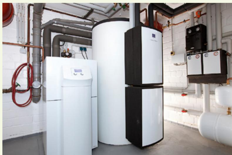
Wärmepumpen sind in Neubauten sehr beliebt. Sie nutzen ein Kältemittel, das die Umwelt- oder Erdwärme erst aufnimmt und dann zum Heizen verdichtet, sowie auf ein höheres Energieniveau gebracht wird. Bei andauernden, sehr niedrigen Außentemperaturen kann ein oft eingesetzter elektrischer temporärer Heizstab zu höheren Stromverbräuchen führen.
